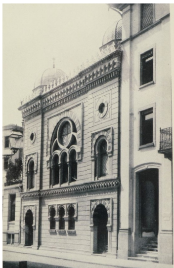
1885 Foto aus der Schweizerischen Bauzeitung
